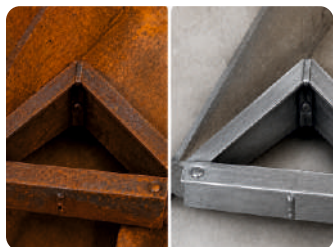
ОЧИСТКА ОТ РЖАВЧИНЫ
